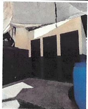
Foto 3: Sustitución de techo pasillo para baños.
