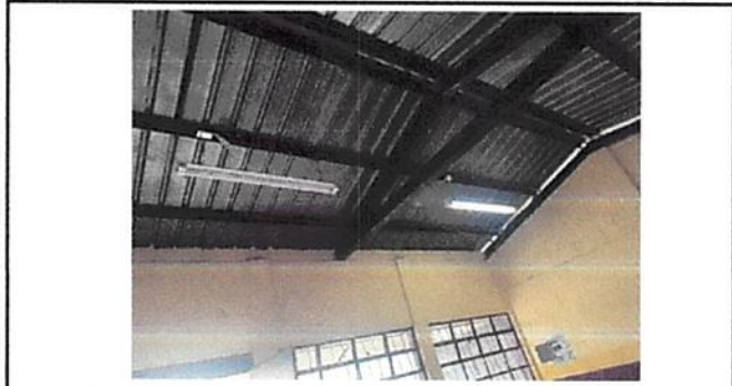
Foto 3: Sustitución de lámparas LED.
