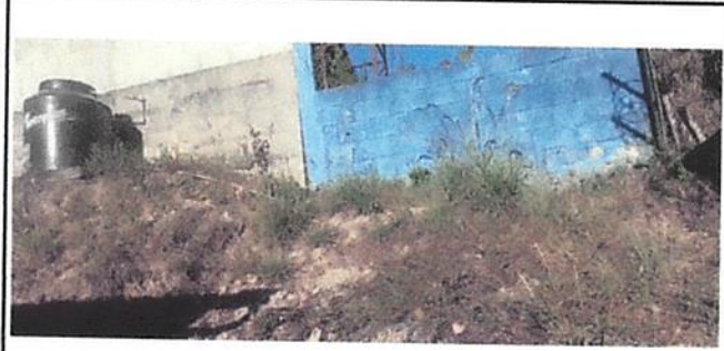
Foto1: Mejoramiento del acceso al tanque de agua.
