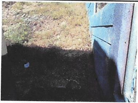
Foto 2: Mejoramiento del acceso al tanque de agua.
