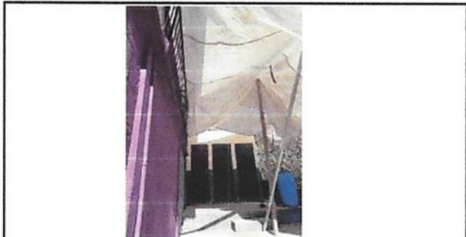
Foto 5: Mejoramiento de techo.
