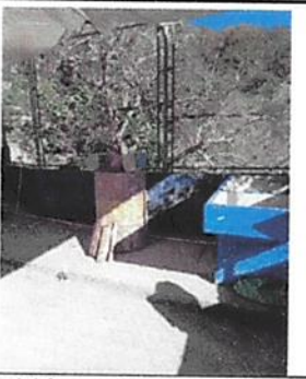
Foto 5: Mejoramiento del área de cocina
